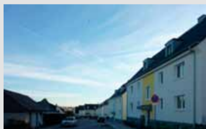
Foto: Nach der Modernisierung
