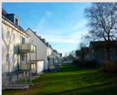
Foto: Nach der Modernisierung
