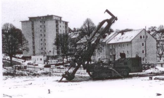
79 Sondierungsbohrungen wurden mit Spezialgerät vorgenommen. FOTO: H.-W. RIECK
